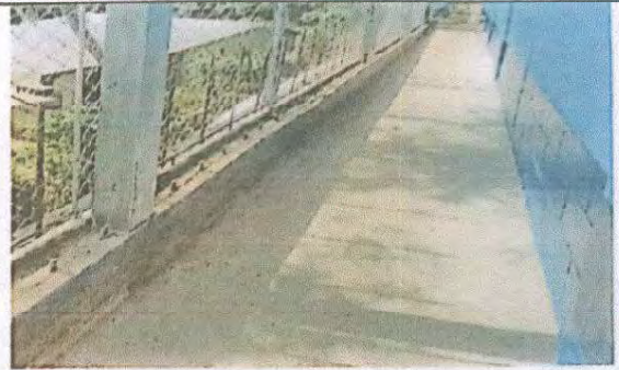
Foto 8: Reparación de banquetas de concreto en la parte de atrás del Módulo Aulas.
