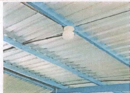
Foto 10: Sustrucción de lámparas tipo LED 50 wats del Módulo Aulas.
