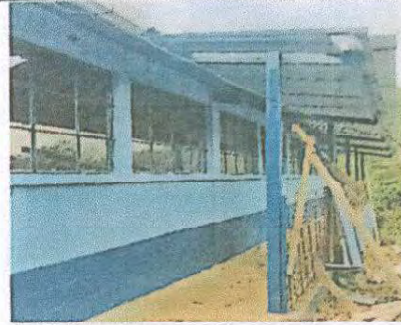
Foto 2: Sustrucción de estructura de soporte de madera, por metal en la estructura de Módulo Aulas.
