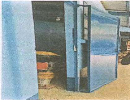
Foto 3: Mantenimiento a estructura (fijado, cambio de tubo, cepillado, sujeciones, aplicación de pintura) de las puertas de metal del Módulo Aulas.
