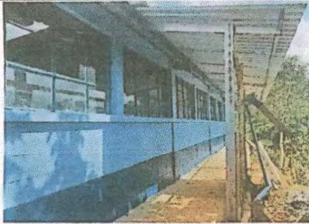
Foto 1: Sustrucción de lámina, por lámina troquelada aluzinc calibre 26 del Módulo Aulas.
