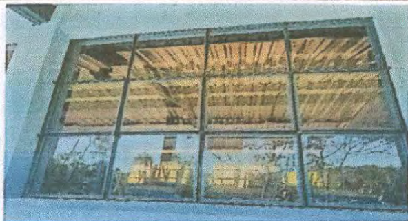
Foto 5: Sustrucción de vidrios en las ventanas del Módulo Aulas.
